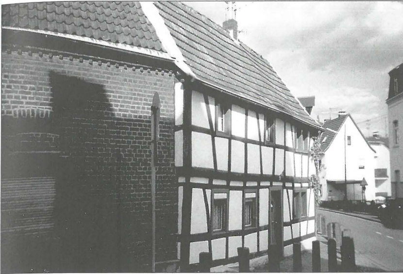
< Gebäude (17. Jh.) der ehemaligen Gaststätte „Zur Kütz“ an der Ecke Larstraße/ Eintrachtstraße. Der Ziegelsteinanbau wurde für das Billardspiel errichtet.
