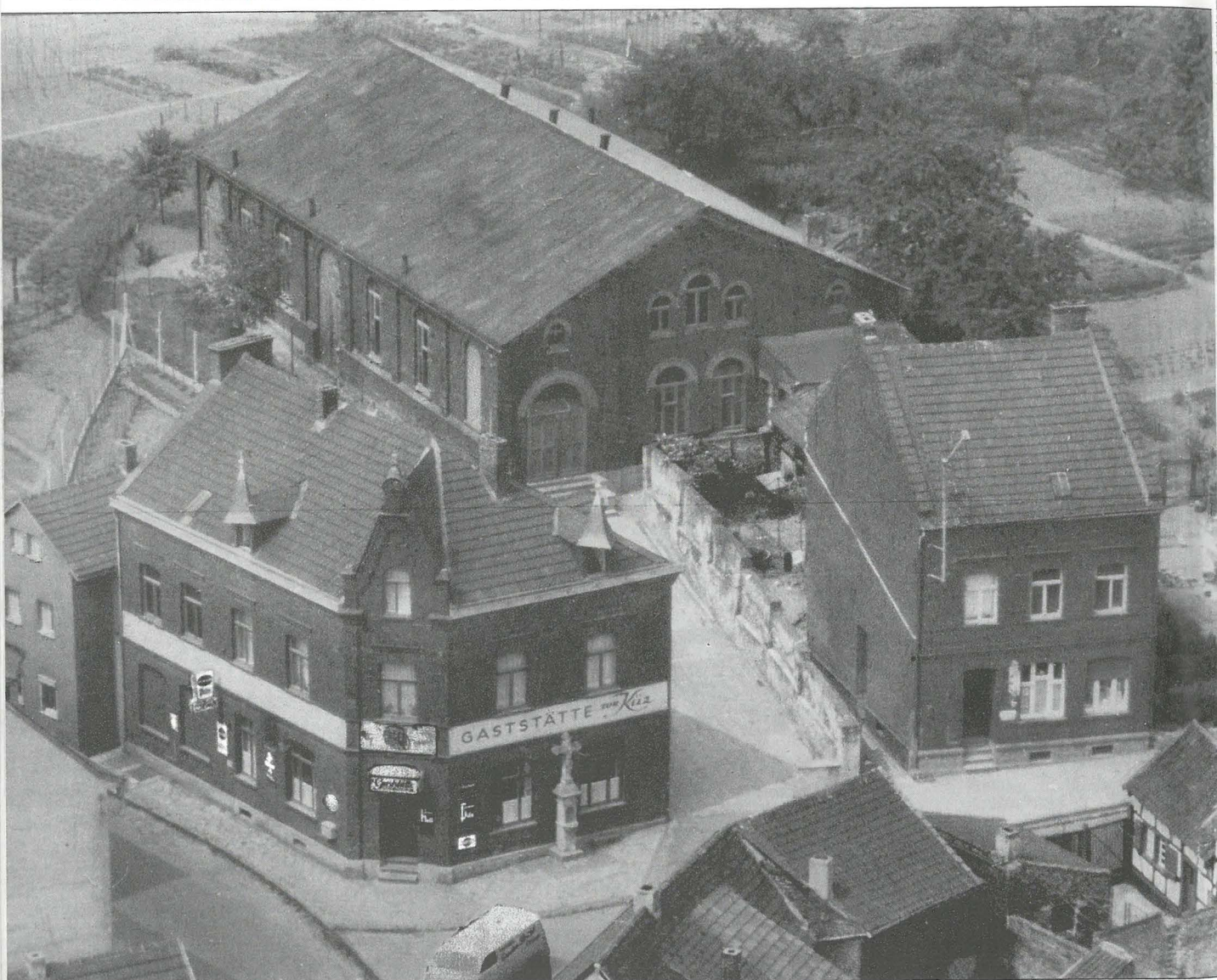
Gaststätte und Saal „Zur Küz“ vor der Umgestaltung zum Sieglarer Bürgerhaus.
