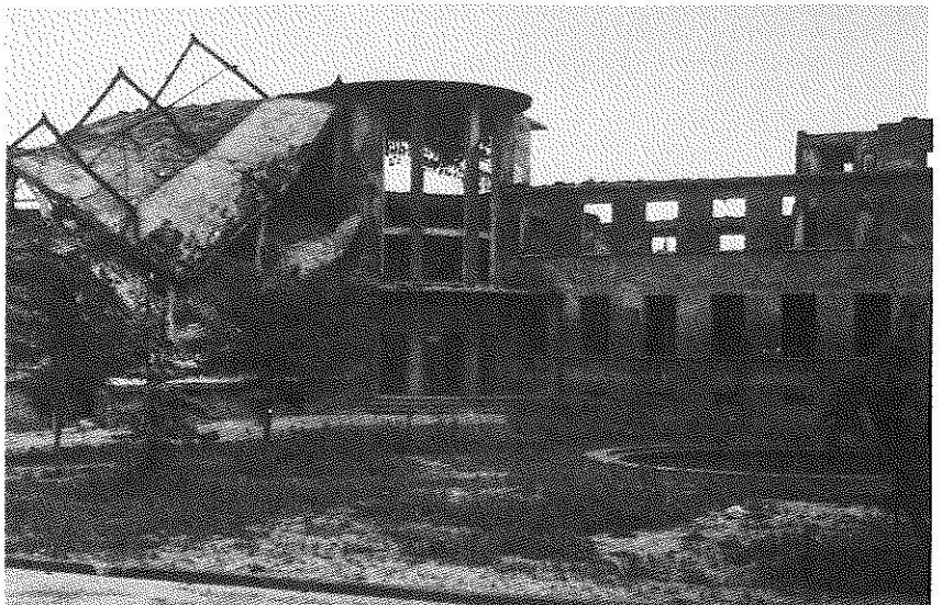
10 Das Hauptverwaltungsgebäude der Dynamit AG nach der Zerstörung.
