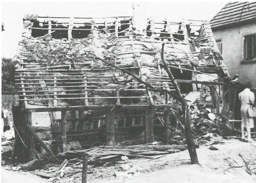
Der Luftdruck dieser ersten Bomben machte den Anbau abbruchreif.
