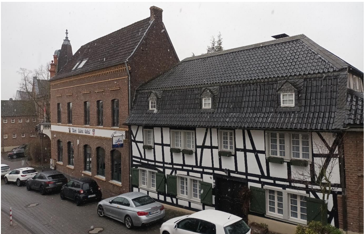
Abb. 5: Denkmalwerte Bausubstanz, backsteinsichtiges Wohn- und Gasthaus „Zum Lööre Oohs“ (links) und Fachwerkwohnhaus Meindorfer Straße 10 (rechts)
