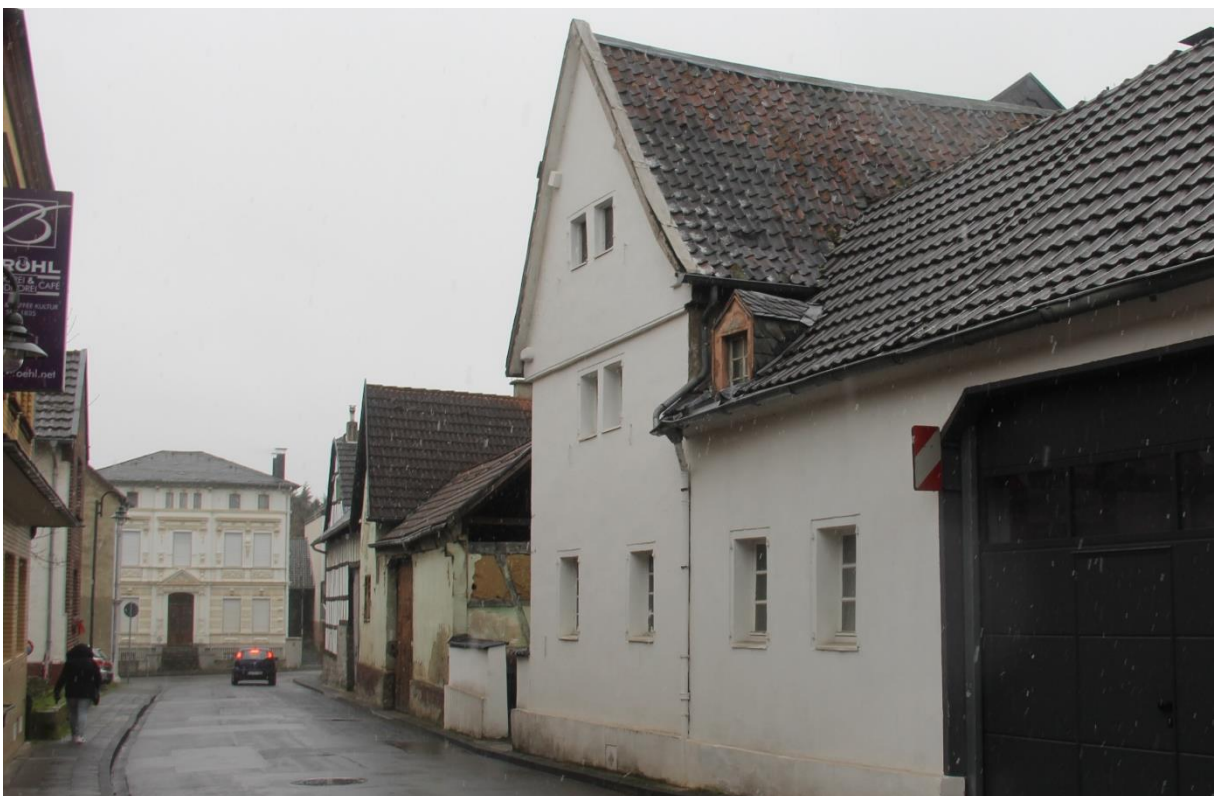
Abb. 9: Giebelständige Satteldächer (Larstraße) mit dunkelgrauen Ziegeln und kleinproportioniertem Dachaufbau Quelle: Planungsgruppe MWM 2023
