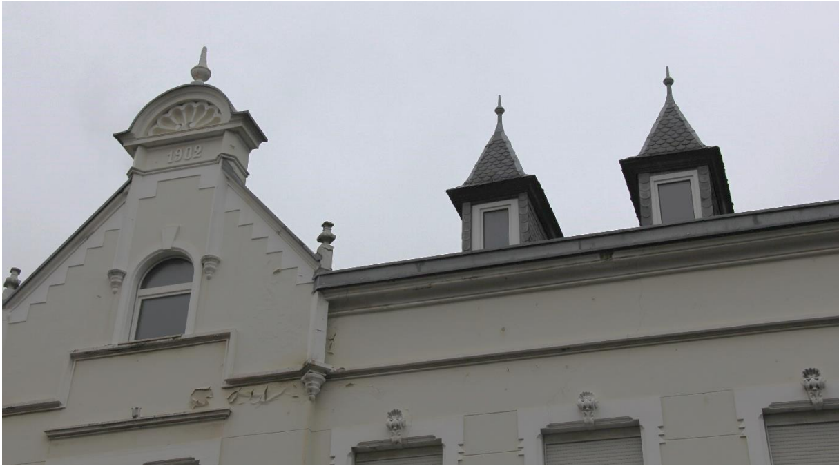
Abb. 10: Kleinproportionierte Dachaufbauten (Wohnhaus Larstraße 142) Quelle: Planungsgruppe MWM 2023
