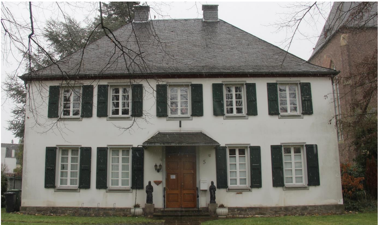
Abb. 11: Weißgefasste, hochformatige und durch Flügel geteilte Fenster, kleinteilige Gliederung mit Sprossen (Pfarrhaus, Meindorfer Straße 5) Quelle: Planungsgruppe MWM 2023
