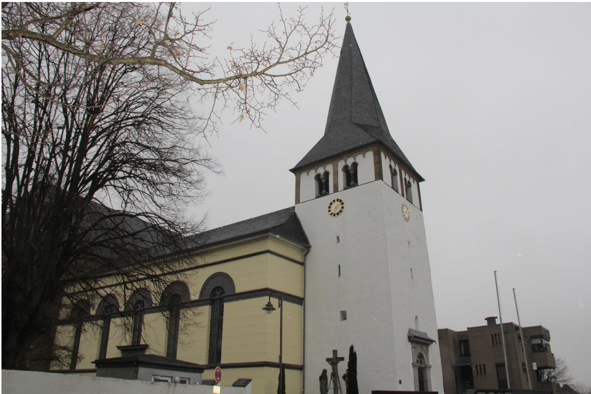
Abb. 4: Denkmalwerte Bausubstanz, Solitärbau (Pfarrkirche St. Johannes)
